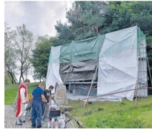
Für die Sandstrahlarbeiten wurde die gesamte Konstruktion eingehaust.
